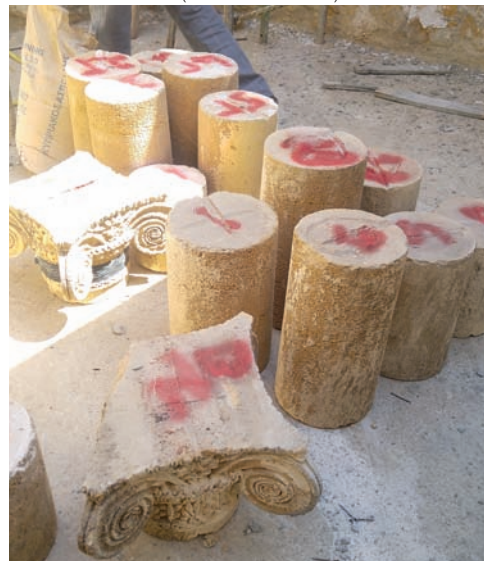
ΕΡΓΑΣΙΕΣ ΑΠΟΣΥΝΑΡΜΟΛΟΓΗΣΗΣ ΚΑΙ ΣΥΝΤΗΡΗΣΗΣ ΤΩΝ ΥΠΟΣΤΥΛΩΜΑΤΩΝ. (ΑΡΧΕΙΟ Ε. ΣΟΦΙΑΝΟΥ)
