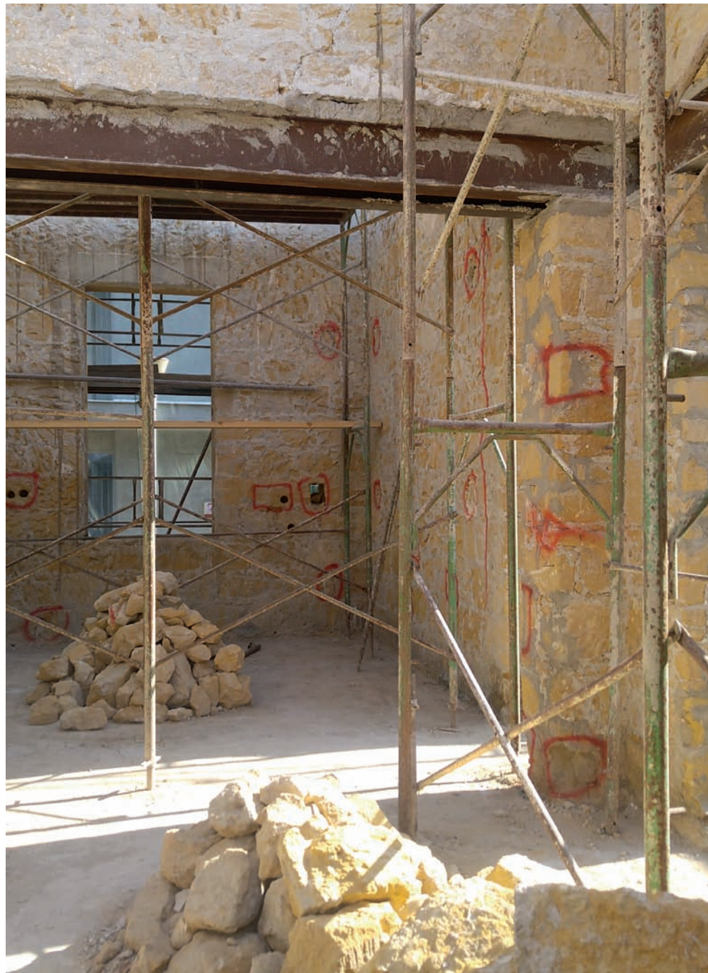
ΕΡΓΑΣΙΕΣ ΑΠΟΚΑΤΑΣΤΑΣΗΣ ΤΩΝ ΛΙΘΟΔΟΜΩΝ. (ΑΡΧΕΙΟ Ε. ΣΟΦΙΑΝΟΥ)
